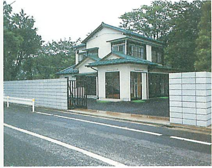
会館 (正面より)
