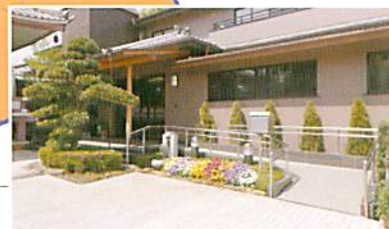
●玄関・スロープ
